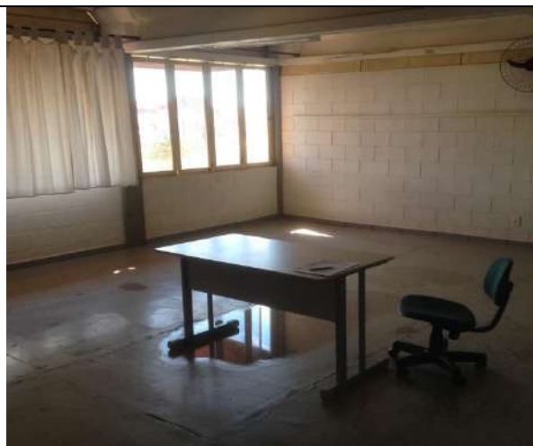
Goteira localizada no centro da sala
