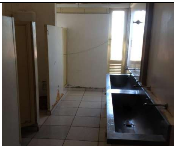
Banheiro sem piso impermeável e antiderrapante.
