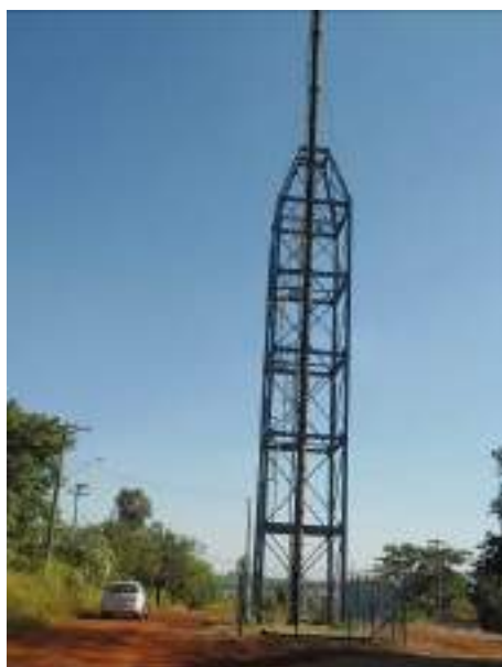
FIGURA 102. Stand Pipe na Adutora de Água Bruta.
