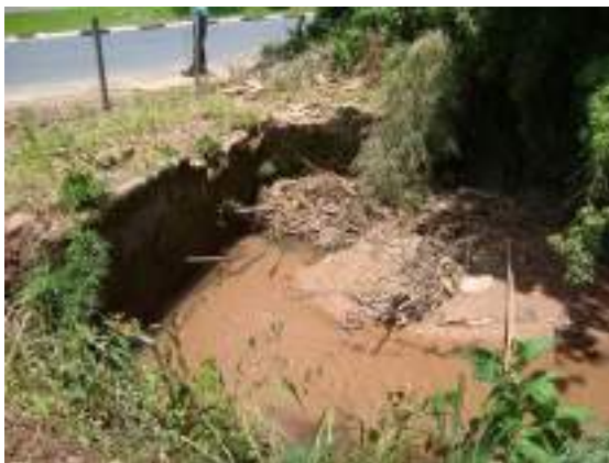
FIGURA 166. Montante da travessia do Ponto P16, tubulação DN 600 obstruída e local assoreado.
